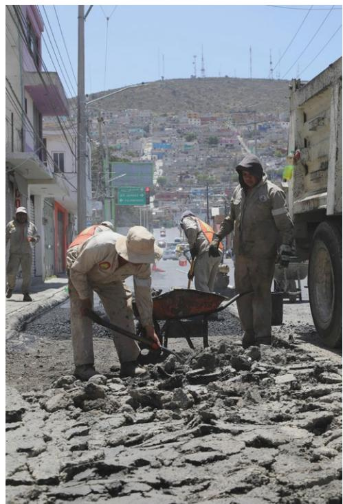
Los trabajos consisten en intervenciones técnicas integrales, que incluyen corte, perfilado, compactación, colocación de carpeta asfáltica y sellado, lo que permite mayor durabilidad y uniformidad en las superficies rehabilitadas.
